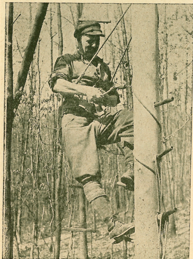
Obr. 4. Chceme-li postihnout celý profil porostního ovzduší od povrchu půdy až nad koruny stromů, jsme zatím nuceni — nemajíce dálkových registračních zařízení — budovat vysoké konstrukce, které umožní upevnění přístrojů a výstup pozorovatele. Na snímku stavba konstrukce mikroklimatické stanice. Foto Ing. Krečmer.
